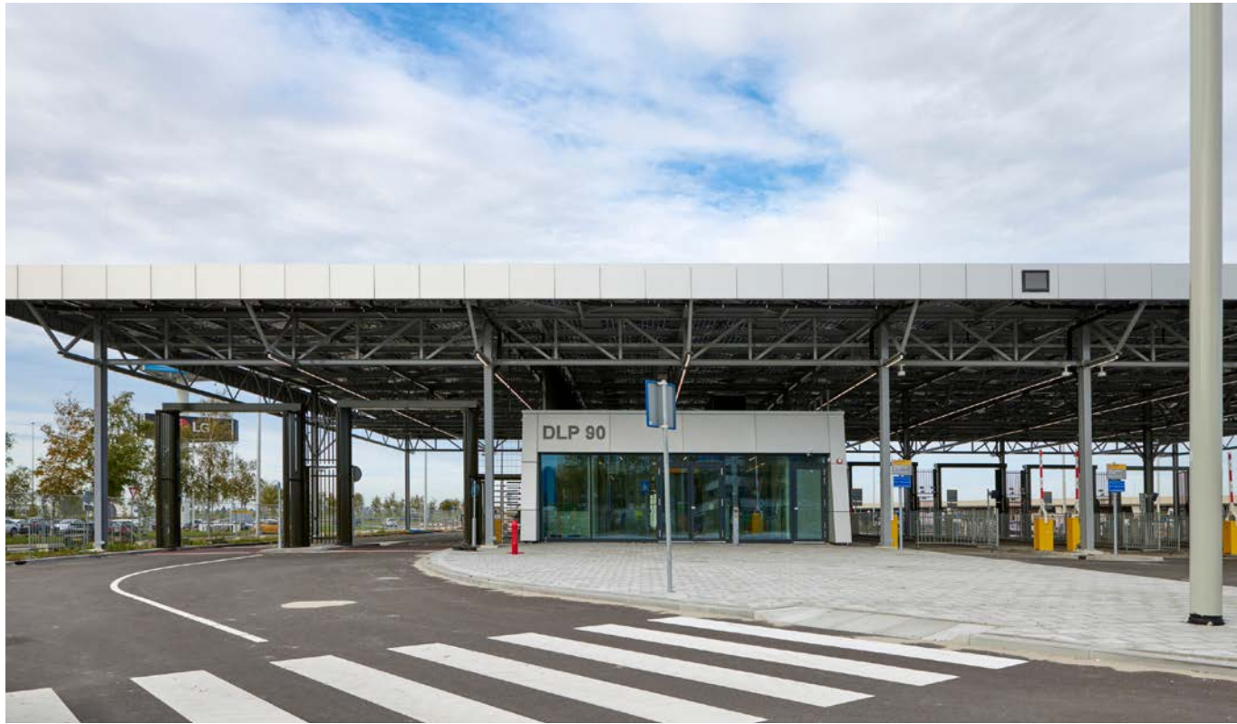
Doorlaadpost 90 is een toonbeeld van slim hergebruik.
